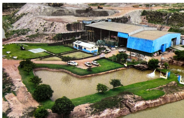
Minério britado é alimentado e processado nas plantas de beneficiamento
